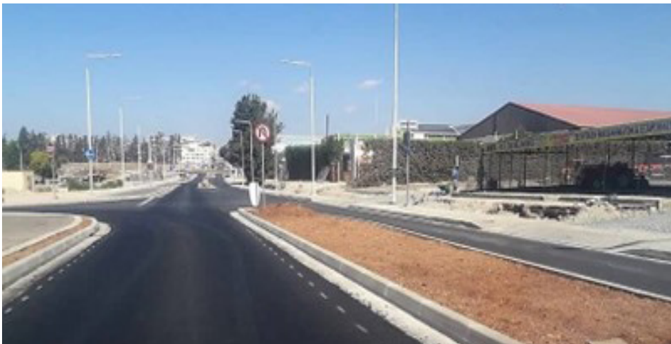
Βόρειος παρακαμπτήριος δρόμος Πάφου - Γεροσκήπου
