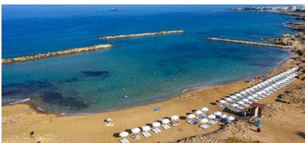
Ολοκλήρωση των κυματοθραυστών στην περιοχή Venus Beach Hotel
