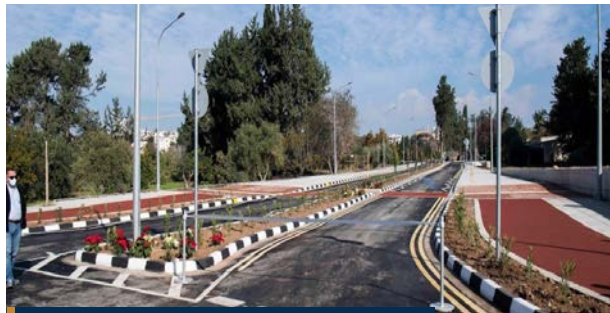
Κατασκευή τμήματος της οδού Σωτηράκη Μαρκίδη
