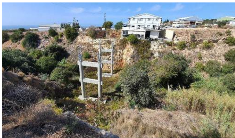
Ι Γέφυρα σύνδεσης της Βιομηχανικής περιοχής Μεσόγης με τη Βιομηχανική Ζώνη Τρεμιθούσας.
