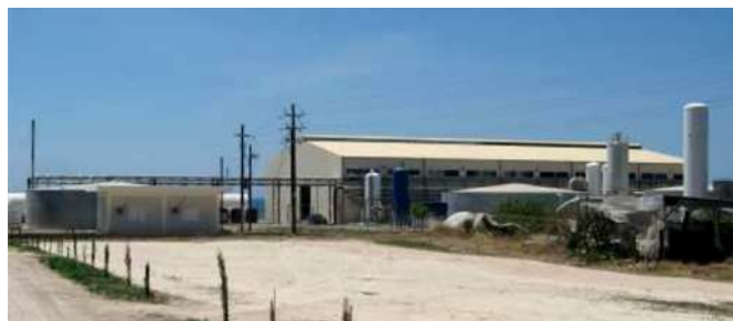
Μονάδα αφαλάτωσης θαλασσινού νερού για την υδροδότηση της περιοχής Μανδριών - Πάφου
